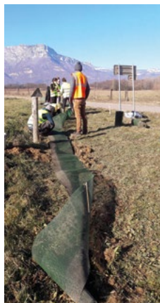
Pose des filets de protection
